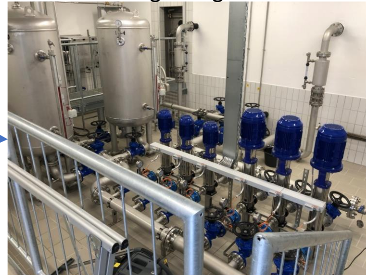
Druckerhöhungsanlage
